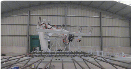
图 12 小箱梁顶板钢筋骨架的自动化安装与绑扎生产线
