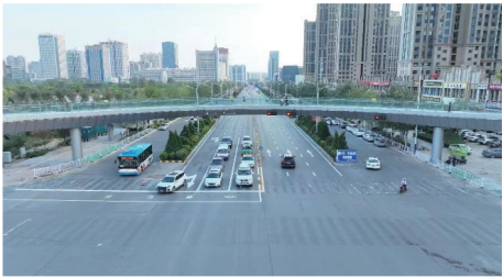
图 2 榆林高新一中人行天桥透视实景
