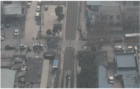
图1 未改造前平面交叉现场
