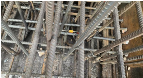
图4 应力测点埋设图
