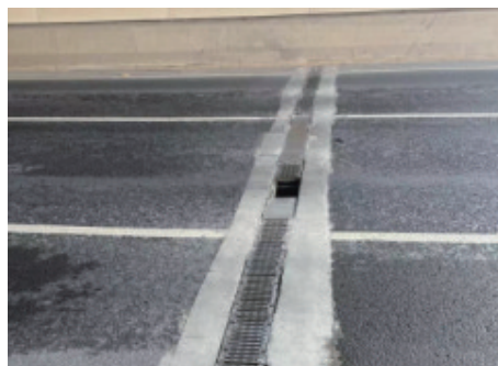
图7 横截式水沟盖板容易缺失或翘起造成跳车现象
