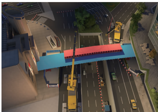
图 7 跨中段吊装施工模拟
