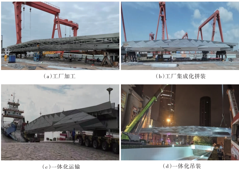
图9 一体化集成拼装施工
