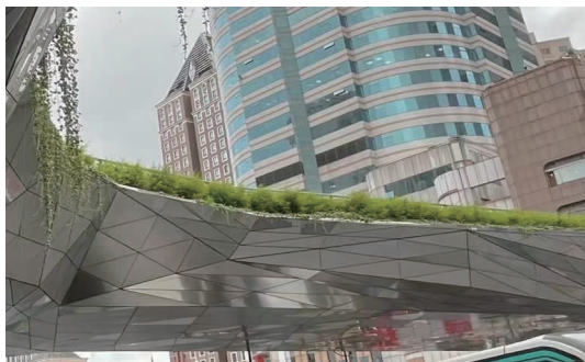
图5 桥下装饰板照片
