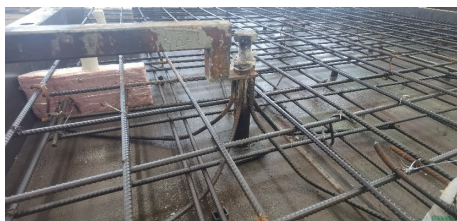
图8 起吊调平构件预埋
