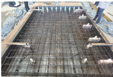
图15 板块钢筋及构件预埋
