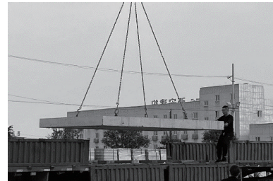
图 4 预制混凝土路面板起吊
