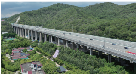
图1 大石吓高架桥侧面照
