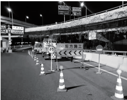
图7 高架施工封路
