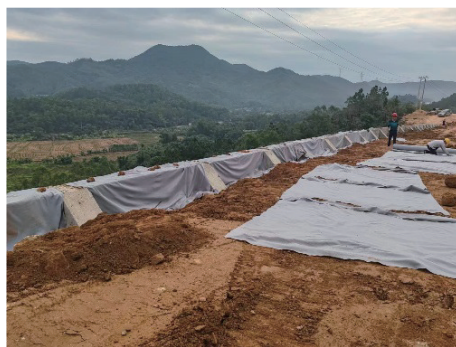
图11 墙后填料回填后现场照片
