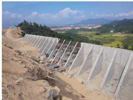
图10 扶壁式挡墙施工后现场照片
