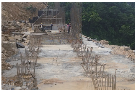
图9 旋挖成孔灌注桩施工后的现场照片
