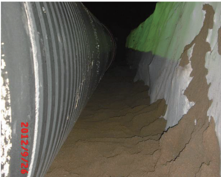
图13 管侧壁底部回填材料
