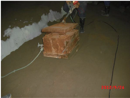
图 15 管顶回填压实处理
