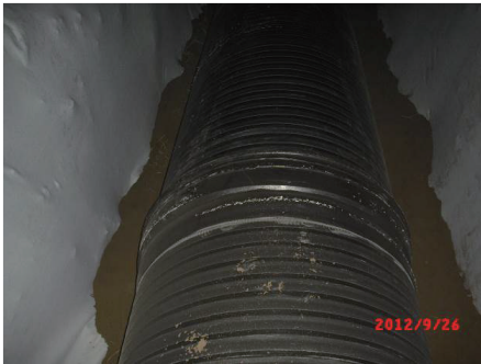
图 16 管材接口细节 1
