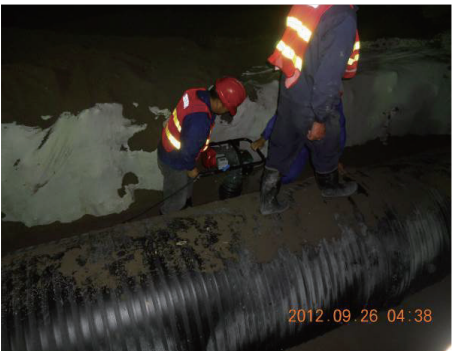
图14 管侧壁沟槽回填压实处理
