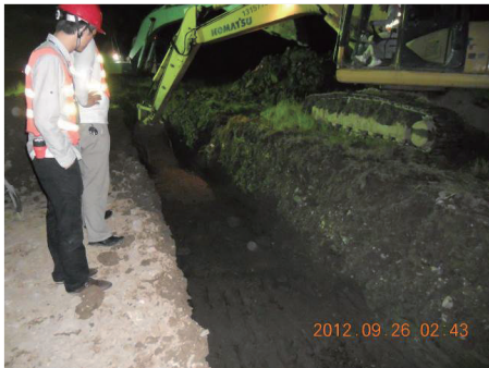
图9 开挖沟槽
