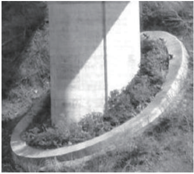
图 3 削竹式护坡示意图
