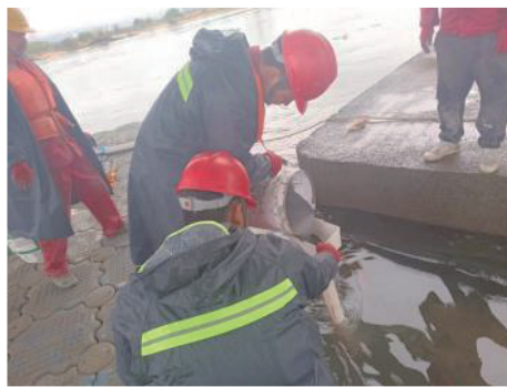
图6 高位漏斗重力灌浆法
