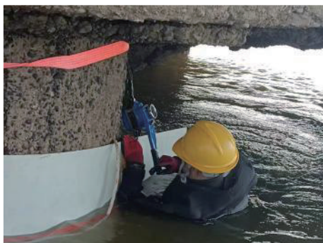
图5 自攻螺钉锚固
