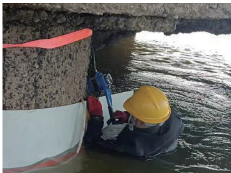
图4 玻纤套筒初步固定
