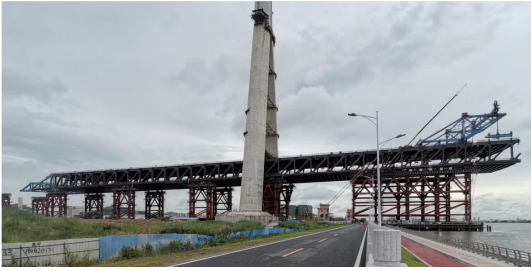
图9 B04 安装到位照片
