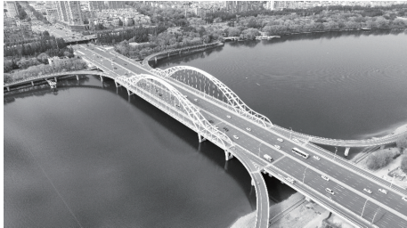
图 1 提篮桁架系杆拱桥建成图
