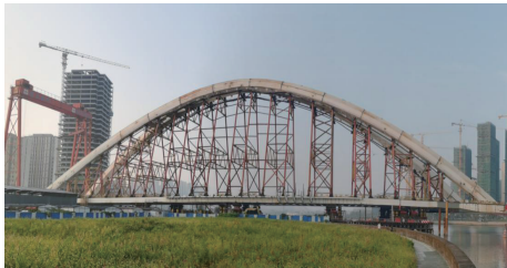
图 11 拱梁间顶推临时撑杆布置图
