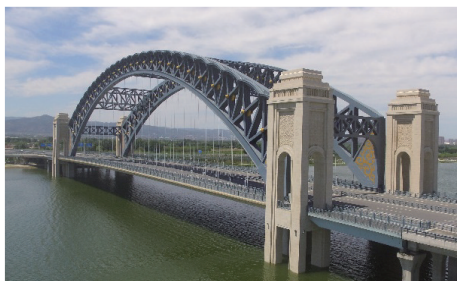
图1 某非闭合上下弦组合受力钢桁拱桥
