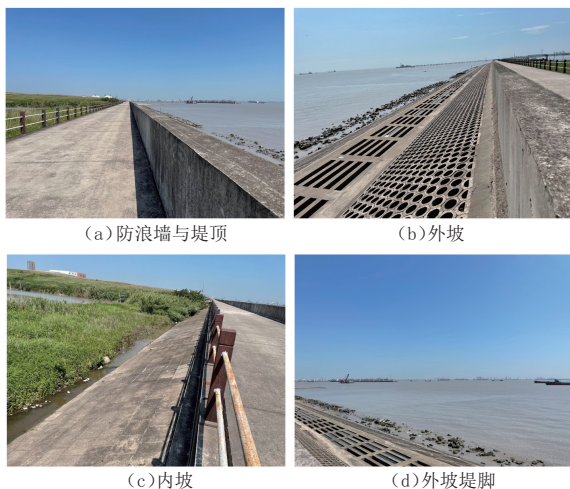
图2 现状海堤整体面貌
