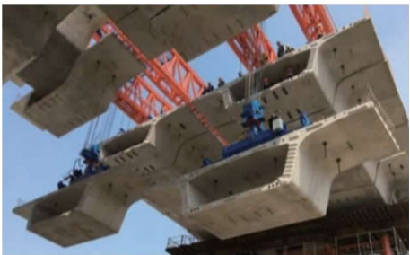
图 13 南昌洪都大道节段梁安装
