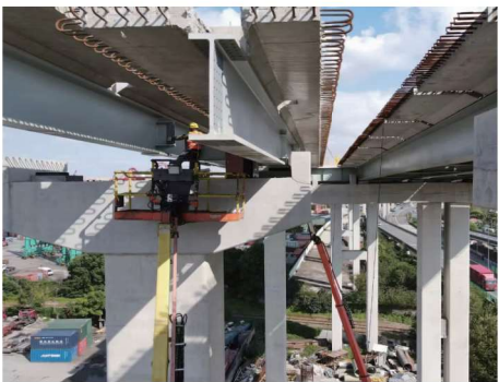
图 12 型钢组合梁安装
