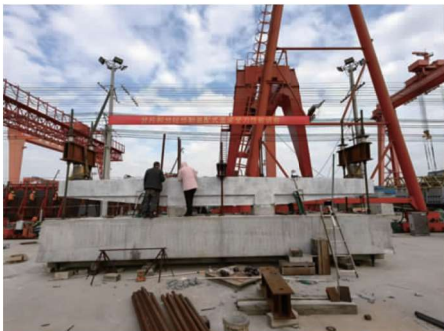
图 2 分片式预制盖梁模型试验
