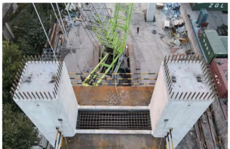
图 5 槽形薄壳安装
