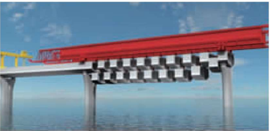
图 16 架桥机先拼装核心梁段
