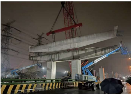
图 3 分片式预制盖梁安装
