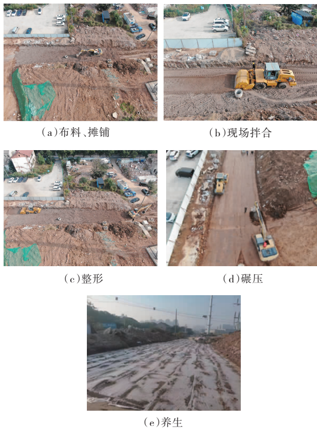
图 9 固化渣土现场施工照片
