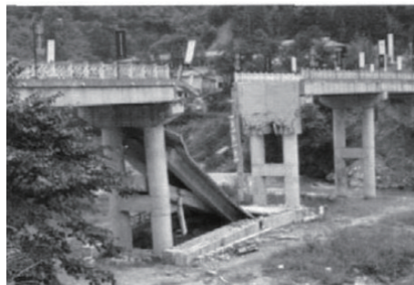
图18 高原大桥(2008年汶川)
