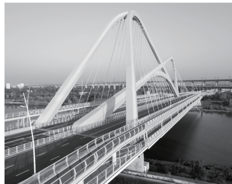
图13 桥位现场实际成桥图
