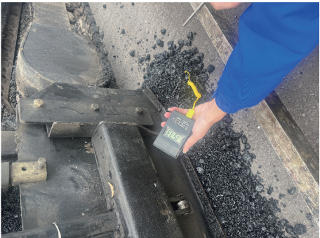
图 8 AC-25 再生混合料摊铺温度
