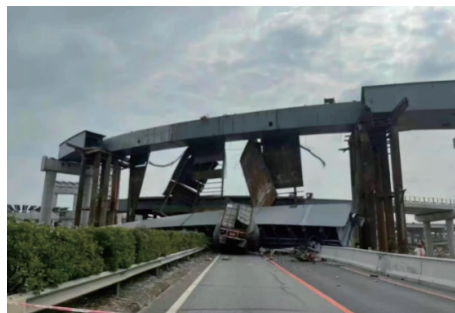
图2 中山西环高速横栏北互通匝道坍塌
