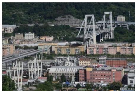
图4 意大利热那亚路桥坍塌
