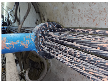
图8 分丝器限位安装效果图
