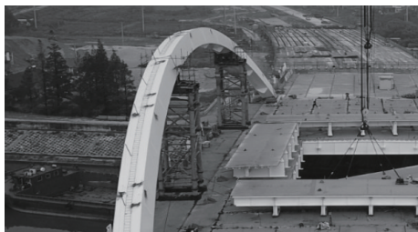
图11 现场拱肋支架生根图1
