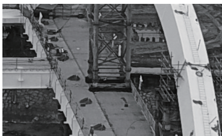
图12 现场拱肋支架生根图2
