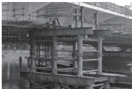
图7 现场支架吊装施工图
