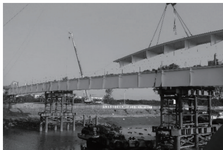
图8 现场支架吊装施工图1
