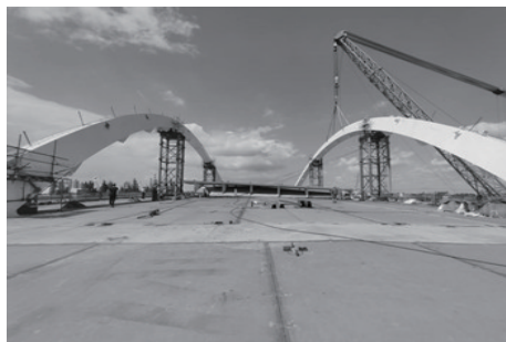
图10 现场拱肋吊装施工图3
