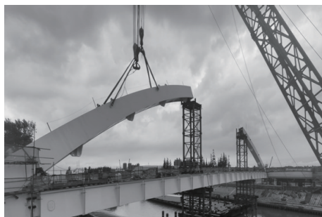
图9 现场支架吊装施工图2
