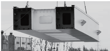
图 6 玻璃段主梁实景图
