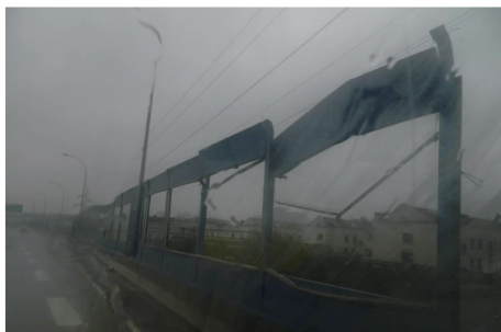
图1 声屏障屏体破坏
