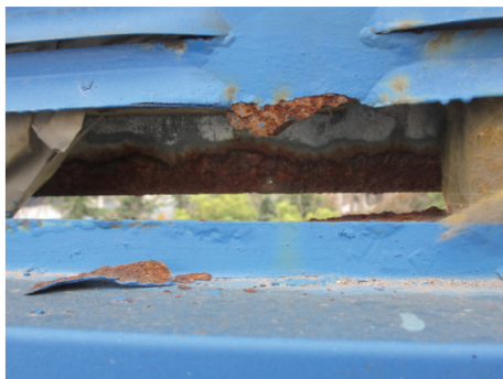
图4 声屏障屏体锈蚀
