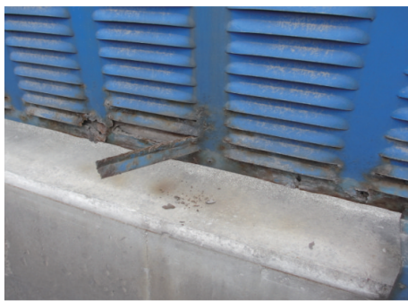
图3 声屏障屏体局部锈断
