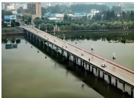
图2 湍河沿线桥梁
