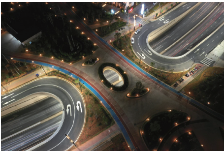
图10 综合管廊顶合建隧道实景照片
