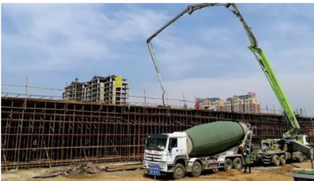
图3 立交桥施工现场
