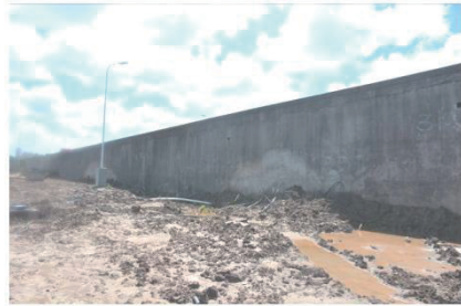
图8 东端北侧挡土墙实景照
