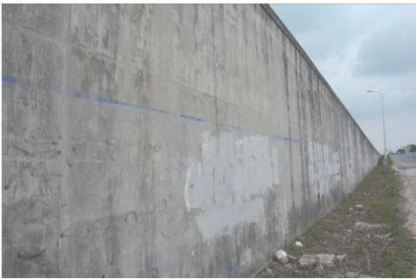
图9 东端南侧挡土墙实景照
