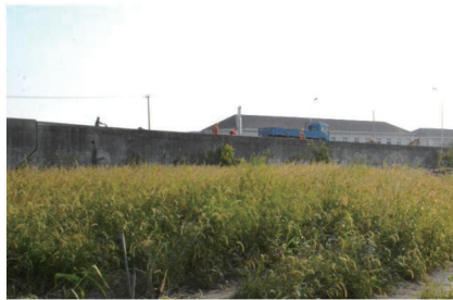
图5 西端北侧挡土墙实景照
