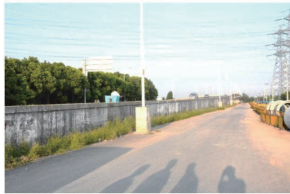
图6 西端南侧挡土墙实景照
