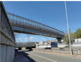
(a)匝道桥侧面
