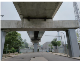
(b)匝道桥下部
