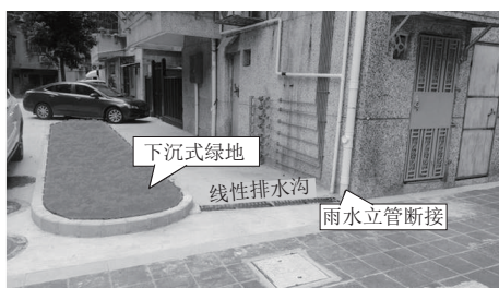
图3 雨水立管断接
