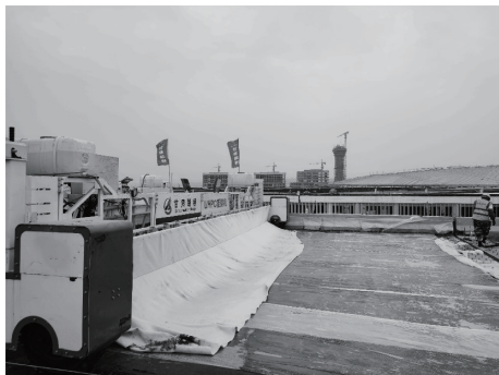
图9 UHPC覆膜施工
