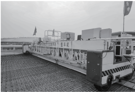
图 1 UHPC 超声波整平机
