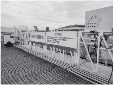
图 2 UHPC 覆膜机
