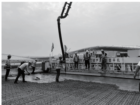
图7 UHPC布料、摊铺
