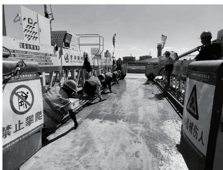
图8 UHPC人工抹平
