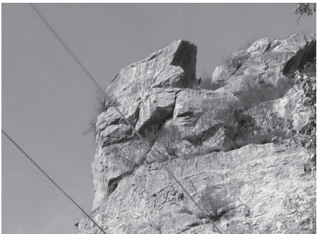
图 3 隧道洞口上方孤石情况
