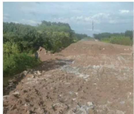
图2 现场施工情况
