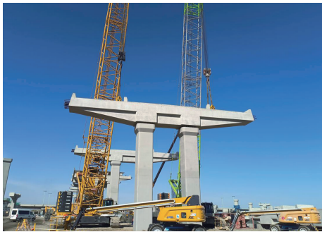
图3 盖梁双台履带吊机吊装
