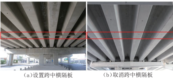
图5 跨中横隔板的优化设计对比图
