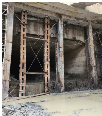
图6 隔离地墙支承格构柱
