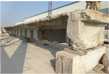
图 2 T 梁实际状况
