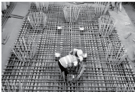
图4 固定端锚具固定托架现场照片
