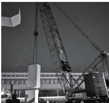
图8 节段立柱吊装现场照片
