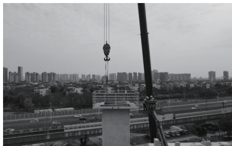
图9 钢绞线穿束现场照片
