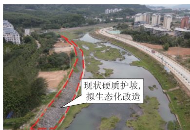
图1 现状护岸为硬质护坡
