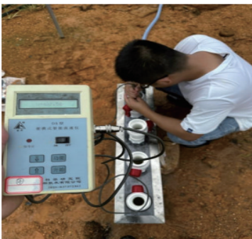
图 4 现场流速调试
