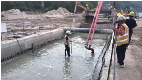
图6 水下混凝土封底
