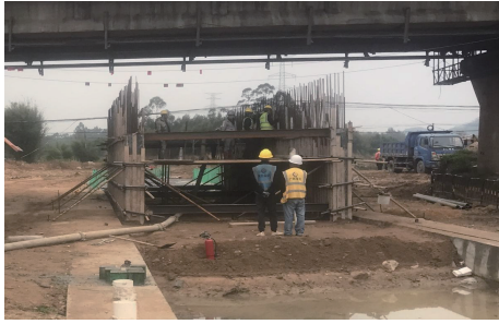
图4 框架侧墙预制
