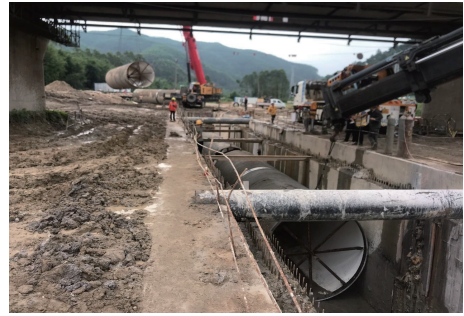
图8 输水管道安装
