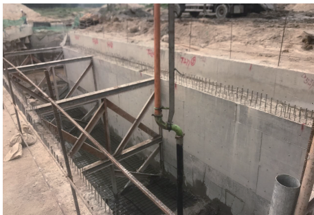
图7 框架底板现浇施工
