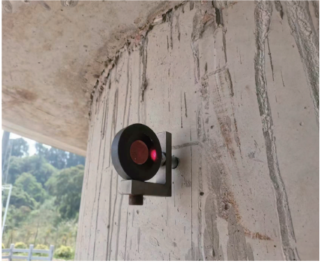
图 10 L-40#墩顶水平位移监测
