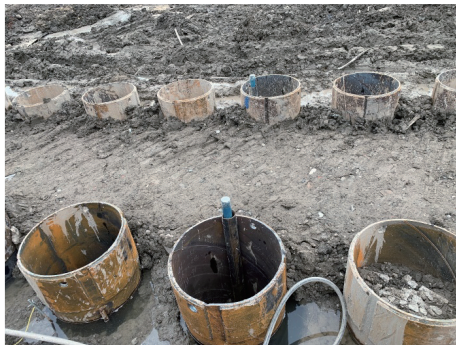
图 6 钢管桩内特制测斜管
