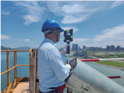
图 7 索导管现场定位
