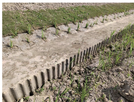
图5 四激港固化土格梗+海绵土护坡(施工过程中照片)
