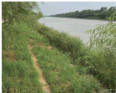
图4 南横引河东段连锁块体护坡
