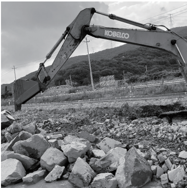
图2 吹填场区石块开挖清理
