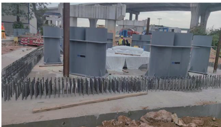
图 13 撑脚现场安装照片
