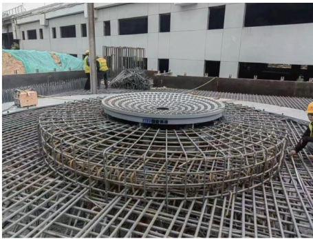
图 12 球铰现场安装照片
