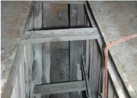
图5 符合要求的支护结构
