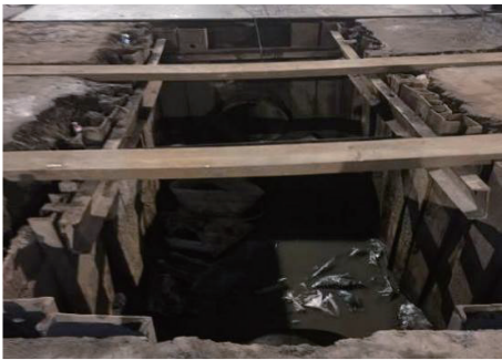
图4 不符合要求的支护结构
